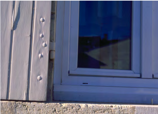
La largeur de profils PVC réduit la surface d'éclaircement
