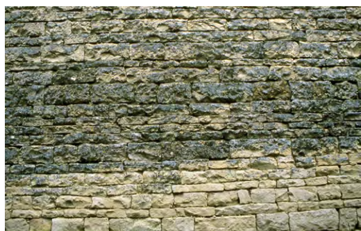
Moellons assisés (de carrière)
