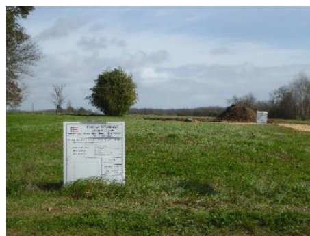
Photo sur site 03/2023 travaux engagés
