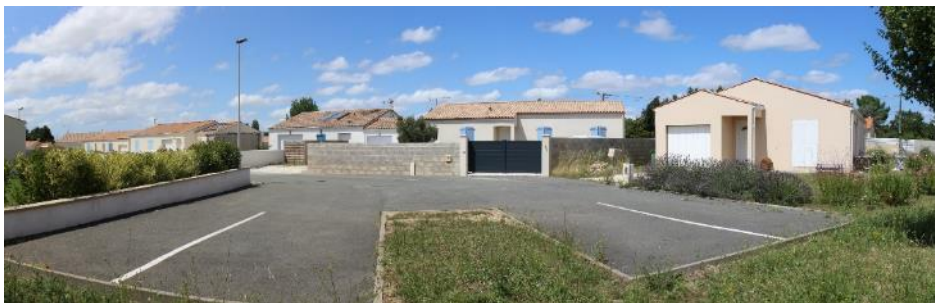
Route de Medis, transition entre plaine agricole et reliefs boisés Source : Atelier du Périscope
