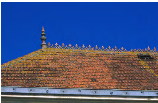
Toit en tuiles losangées avec un épis de faitage
