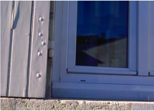
La largeur de profils PVC réduit la surface d'éclaircement
