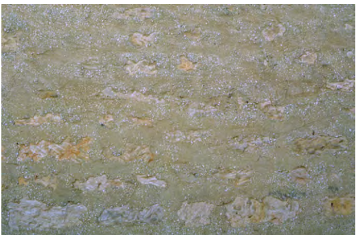
Enduit à fleur de moellons
