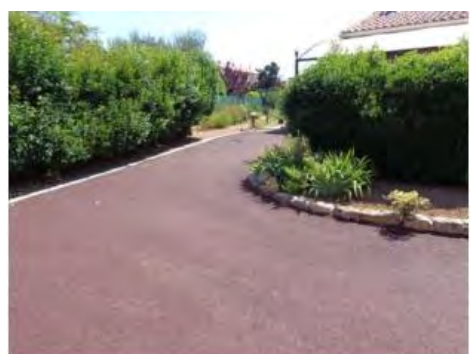
Allée/parking en enrobé poreux (source : Celtivia)
