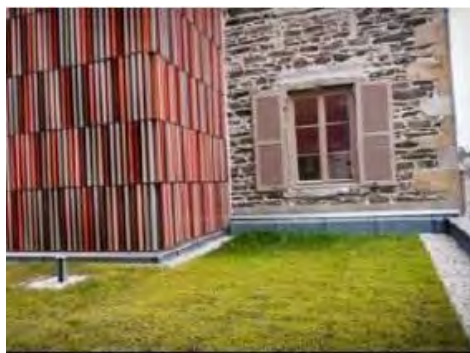
Toiture végétalisée (source : Grand Lyon)
