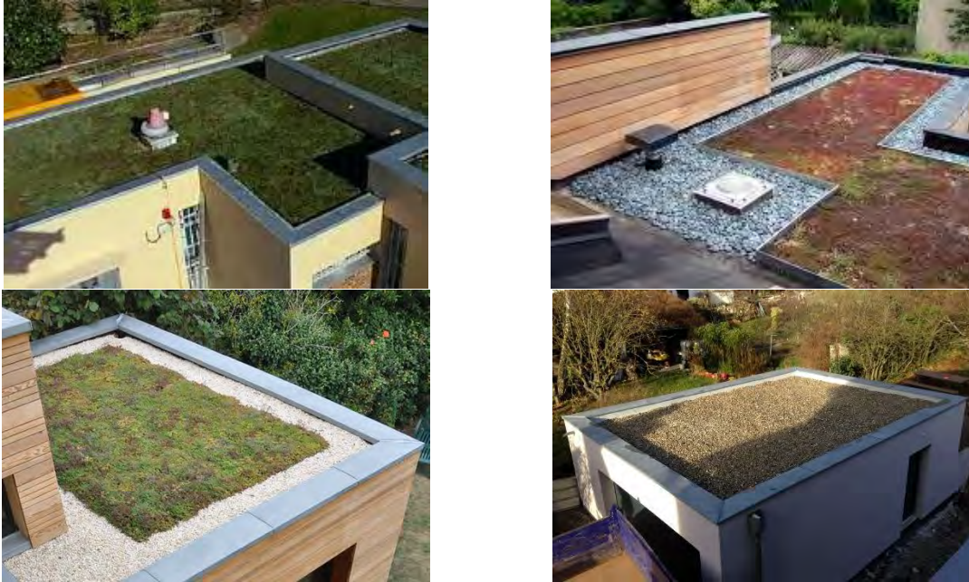
Exemples de toitures stockantes (végétalisées ou non)
