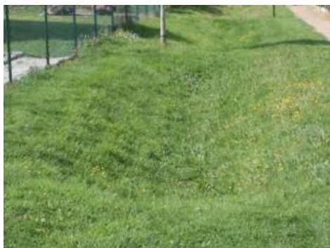
Noue en bordure d'allée (source : Alise Environnement)
